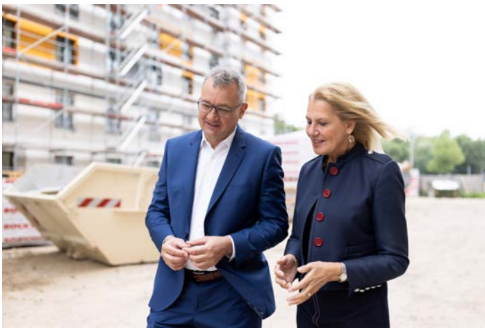
BEIM RUNDGANG geht's auch um Themen wie die Digitalisierung und die Baustelle der Zukunft.
